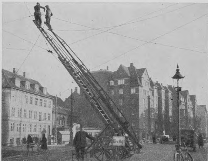
Montering af Gadebelysningsanlæg
