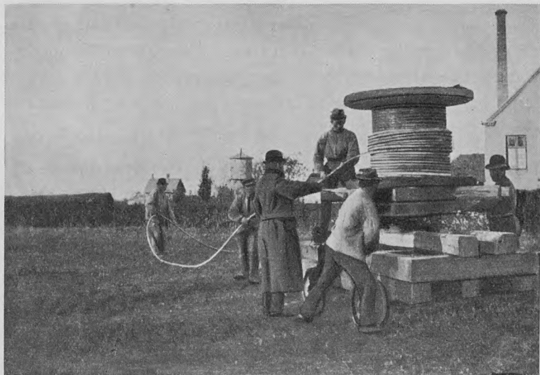
Nedlægning af Kabler i Slagelse 1893
