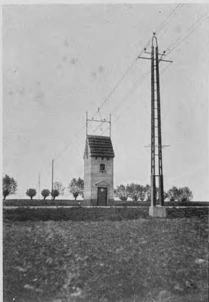
Falsters Højspændingsværk Transformatorstation
