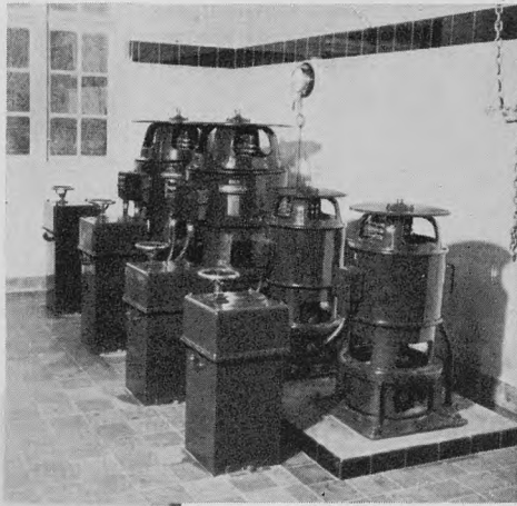
Dybendal Vandværket Lyngby Kommune 1931
